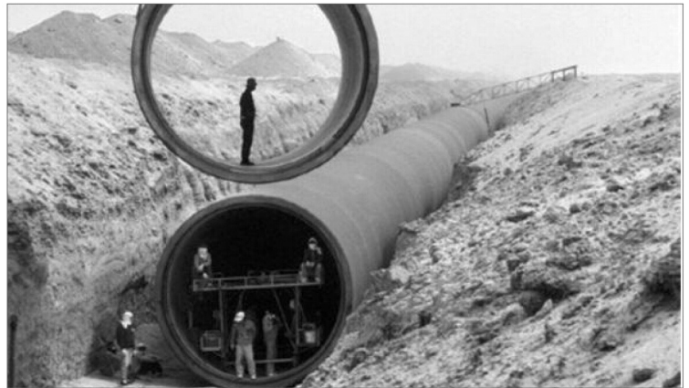
무게 80톤의 PCC 송수관 설치 작업.
